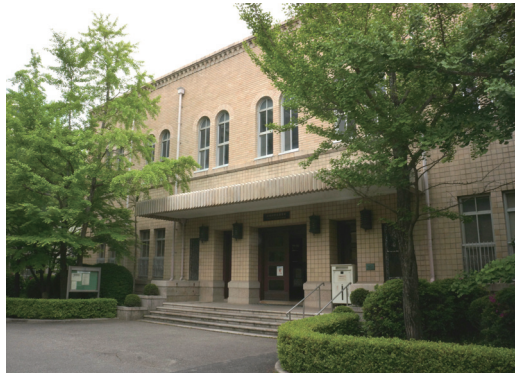
▲ 神戸大学附属図書館社会科学系図書館の正面玄関と本館 2 階天井のステンドグラス ステンドグラスには「KOBEL・UNIVERSITY」の文字が刻まれている 2012(平成 24)年
