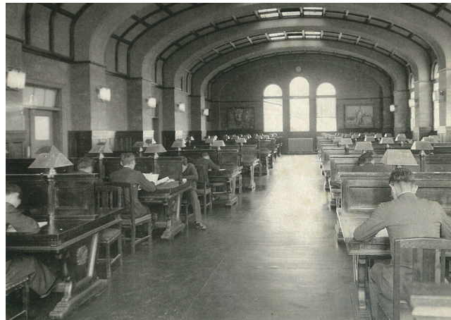
▲ 旧制神戸商業大学附属図書館 2 階「大閲覧室」 1937(昭和 12)年頃
