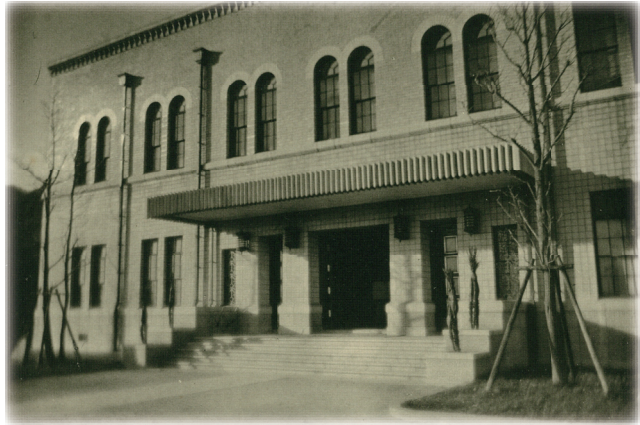
▲ 旧制神戸商業大学附属図書館の正面玄関 1939(昭和 14)年頃
