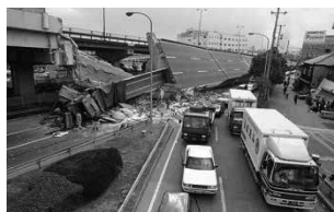
崩れた国道43号岩屋高架橋
