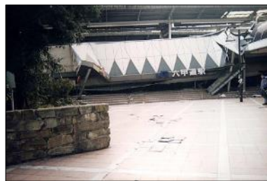
崩れた六甲道駅 (撮影:大浦逸人)
