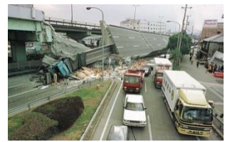
写真: 崩れた国道43号岩屋 高架橋から落ちたトラック。 (前田耕作撮影)
