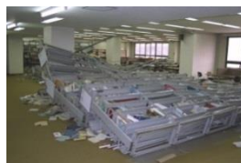
写真：国際・教養系図書室 の倒壊した書架
