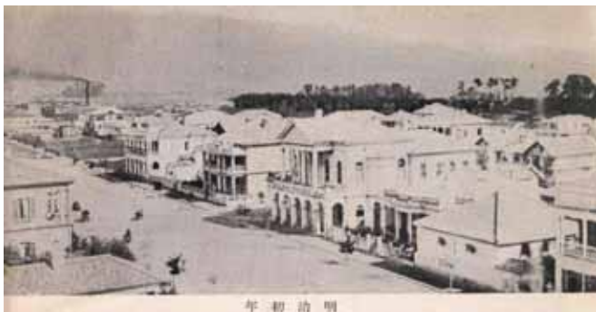
パネル 京町明治初年(「神戸京町と海岸通の風景」一部)
