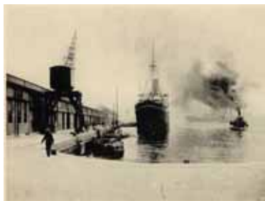
パネル 第一突堤築造後
