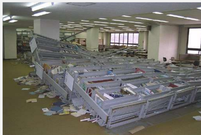
「国際・教養系図書室 2階開架閲覧室/床置き複式書架の将棋倒し、頭繋ぎ無効」(神戸大学附属図書館撮影)
